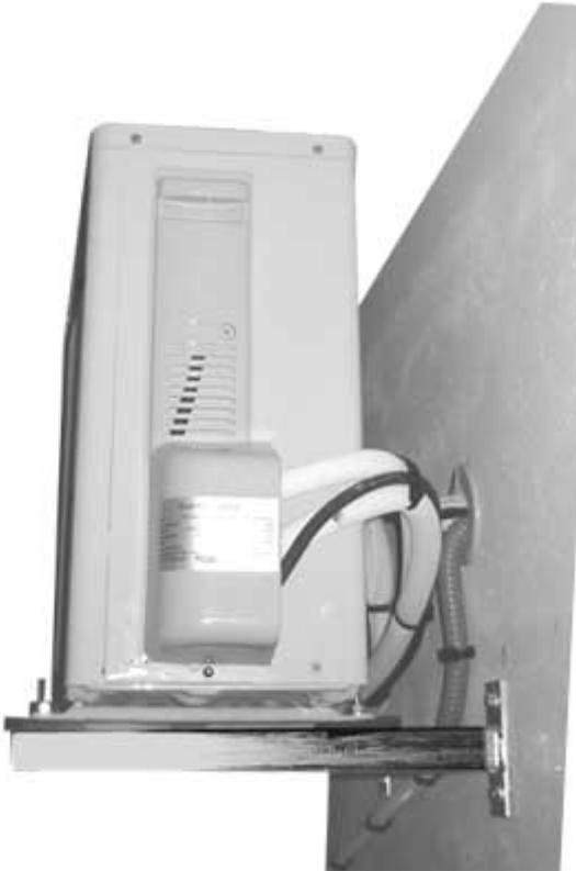
L'unité extérieure doit être posée sur des silentblocs amortissant les vibrations du compresseur. Il ne vous reste plus qu'à raccorder la liaison frigorifique sur l'unité extérieure, les câbles électriques sur le bornier et l'évacuation des condensats à l'endroit le plus approprié.
